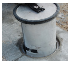
Rundprofilerne står i nogle særlige terrænmuffer - i det daglige lukket med et dæksel, som fjernes let med specialværktøj.
