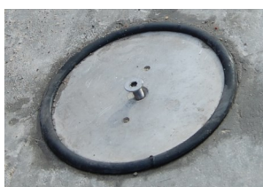
Rundprofilerne står i nogle særlige terrænmuffer - i det daglige lukket med et dæksel, som fjernes let med specialværktøj.
