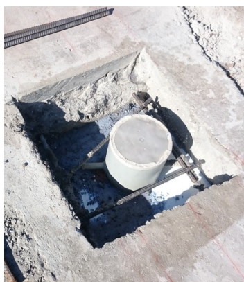
Fundamentet i overkørslen er stærkt armeret - skal kunne tåle kranens vægt.
