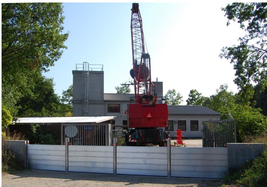
Pumpestation P1 (i baggrunden) deler arealet med Tårnby Kommune og lystbådehavnen. Kommunen har en lille plads for grønt affald og havnen aftenparkerer sin kran lukket inde bag porten.
