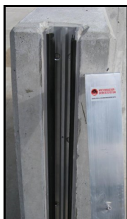
Beskyttelsesdæksler fjernes fra profiler og terrænmuffer
