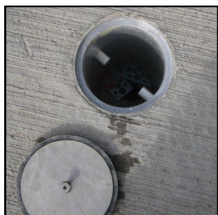
Beskyttelsesdæksler fjernes fra profiler og terrænmuffer
