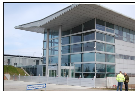
Færdigt arbejde! - 25 meter på ca. en halv time!
