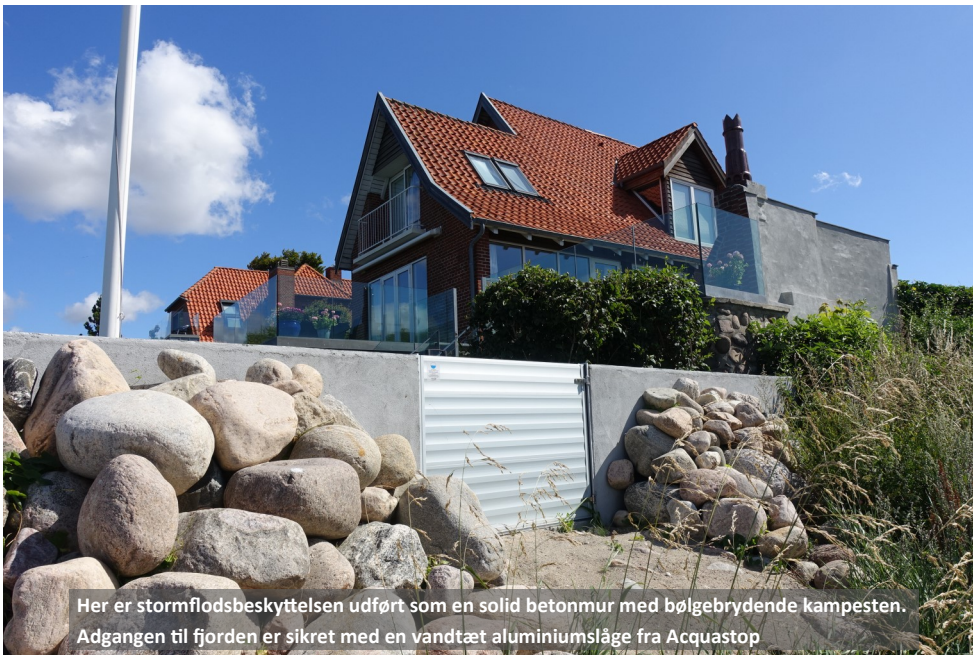
Denne ejendom er beskyttet mod stormflod med en smuk kampestensmur direkte mod fjorden og en 'havemur' mod nord. I forlængelse af husets nordfacade er bygget en trappe til stranden
