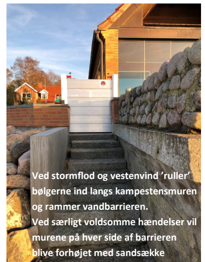
Murgennemrydningen ved trappen er stormflodsbeskyttet med en PREFA Vandbarriere
